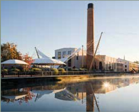
Mangfallkanal mit Turbinenhaus und Seilnetz
