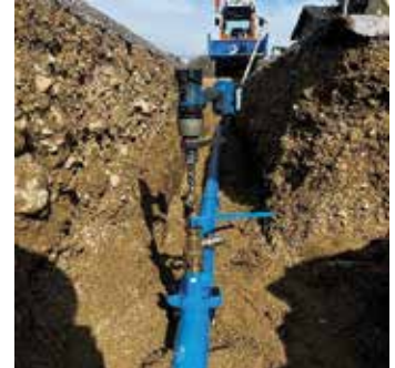
Anbohrung eines Hausanschlusses
