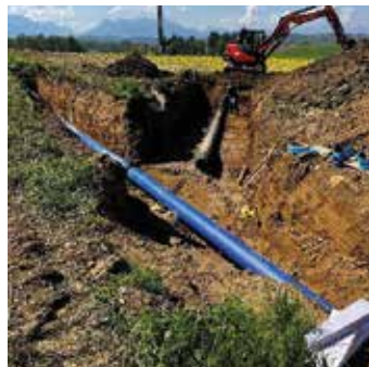
Vorbereitung für die Einbindung
