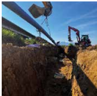
Einhebung der neuen Leitung
