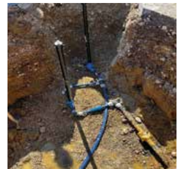
Sanierte Leitung mit Anbindung an Hausanschluss
