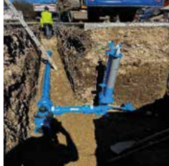
Neuer Abzweig mit Unterflurhydrant
